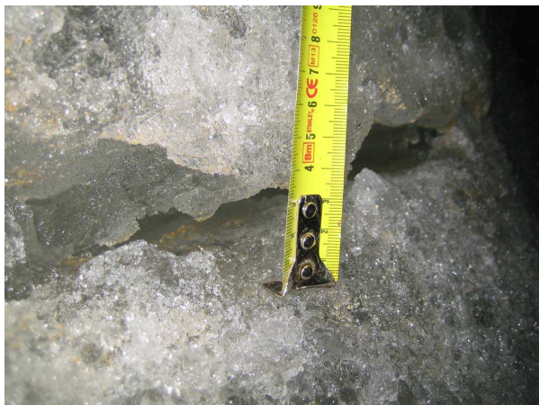
Photo 3 : Fissure horizontale de la cascade.
