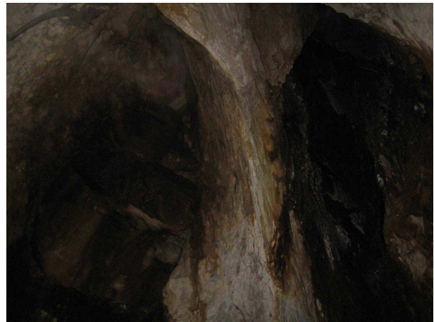
Photo 4 : Cheminées en cloche jointives au niveau du plafond de la salle de la Glacière Sud.
