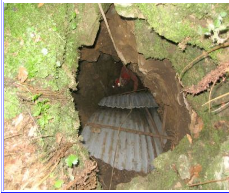
Photo 2 : Pose de tôles à l'entrée ... rudimentaire ... mais efficace !!!
